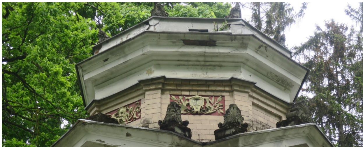
17. Tambura daļā trūkst divi pildīņi –ar maskaronu un ar gadskaitli “1901” kartušā. Pildīņā “1901”lauru lapu ietvērumā attēloti mūrnieka amata rīki, bet virs kartušas delfīna galva.
