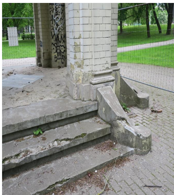
2., 3., 4.Paviljona pamatne un arku liekumi. Ķieģelis nokrāsots. Uzejas pakāpieni laboti, vietām detaļu zudumi. Pakāpienu apmales bojātas, cementa apmetums vietām zudis, nodrupis, atsedzot ķieģeļu mūrējumu.
