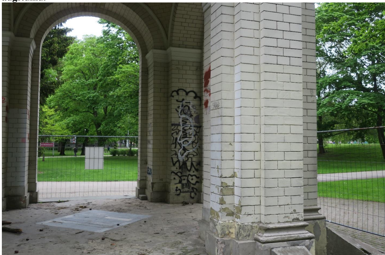
20. Iekštelpa. Paviljona iekšpusē ķieģeļu mūrējums bijis bez krāsojuma, tagad nokrāsots. Šeit ķieģeļu mūrējums mazāk bojāts gan arku, gan pilastru vietās. Arī šeit vietām ķieģeļi nopūsti ar melnu vai sarkanu krāsu, grafiti pseido darinājumi. Betona lējuma grīdas iesegums sliktā stāvoklī, mehāniski bojājumi, izdrupumi.
