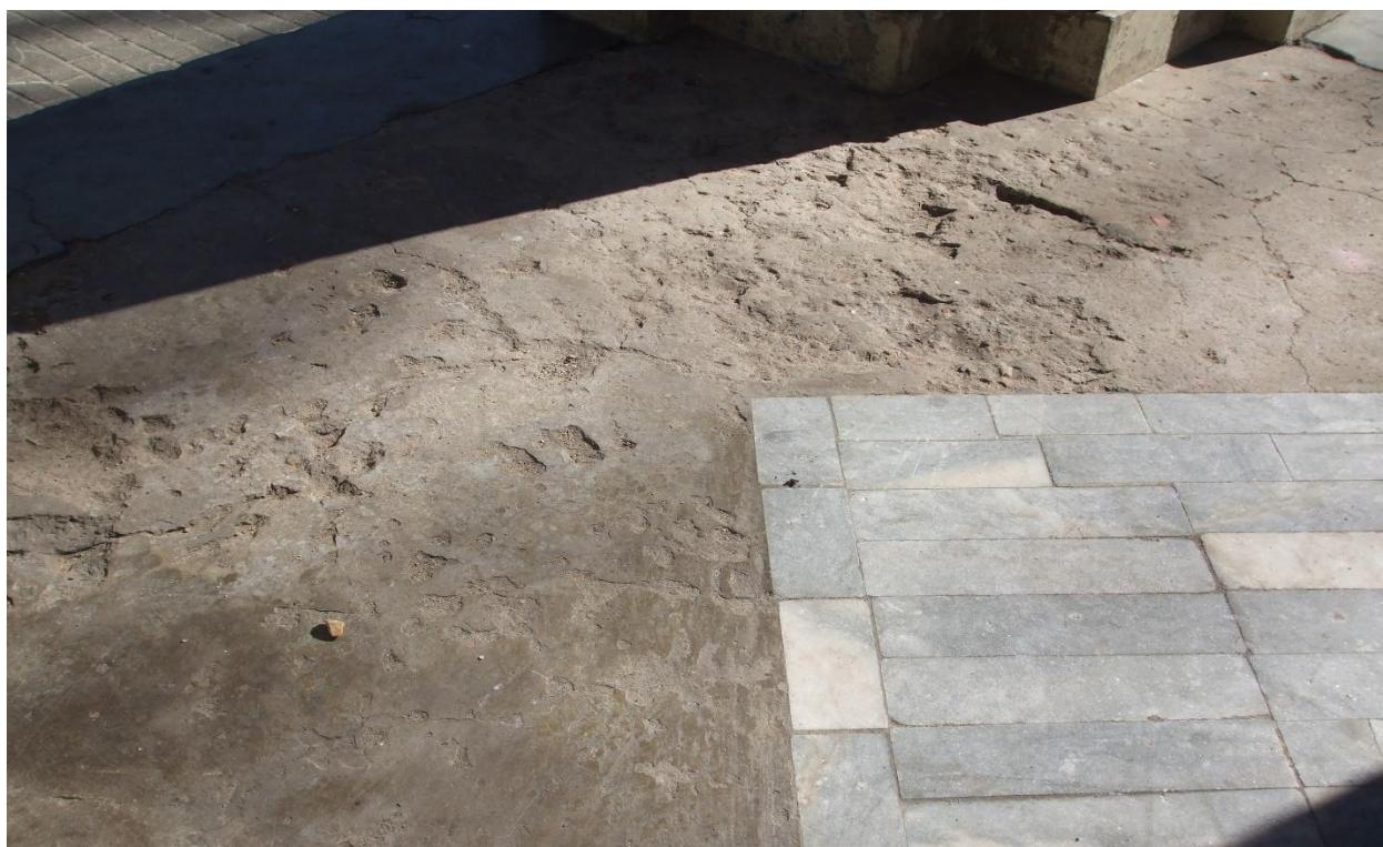
21.,22. Redzams pakāpienu un grīdas ieseguma bojājums. Paviljona centrā ar jaunām flīzēm akcentēta vieta, kur atradies Aleksandra II krūšutēls.
