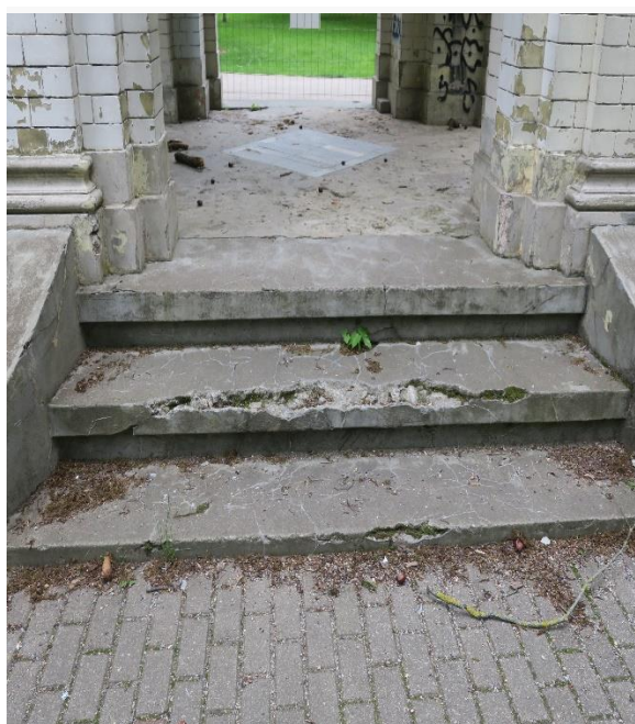
2., 3., 4.Paviljona pamatne un arku liekumi. Ķieģelis nokrāsots. Uzejas pakāpieni laboti, vietām detaļu zudumi. Pakāpienu apmales bojātas, cementa apmetums vietām zudis, nodrupis, atsedzot ķieģeļu mūrējumu.
