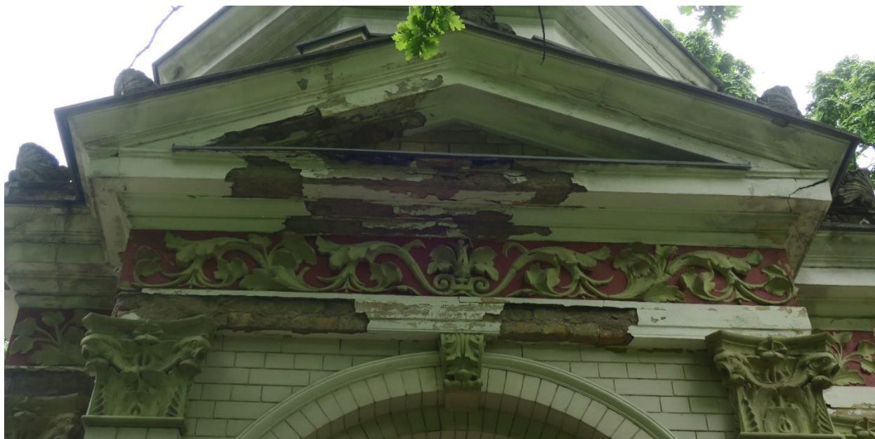
15. Frīzes un frontona dzegām zudis apmetums, redzams dzeltenais ķieģelis. Jārestaure. Trūkst 3 akrotēriji.
