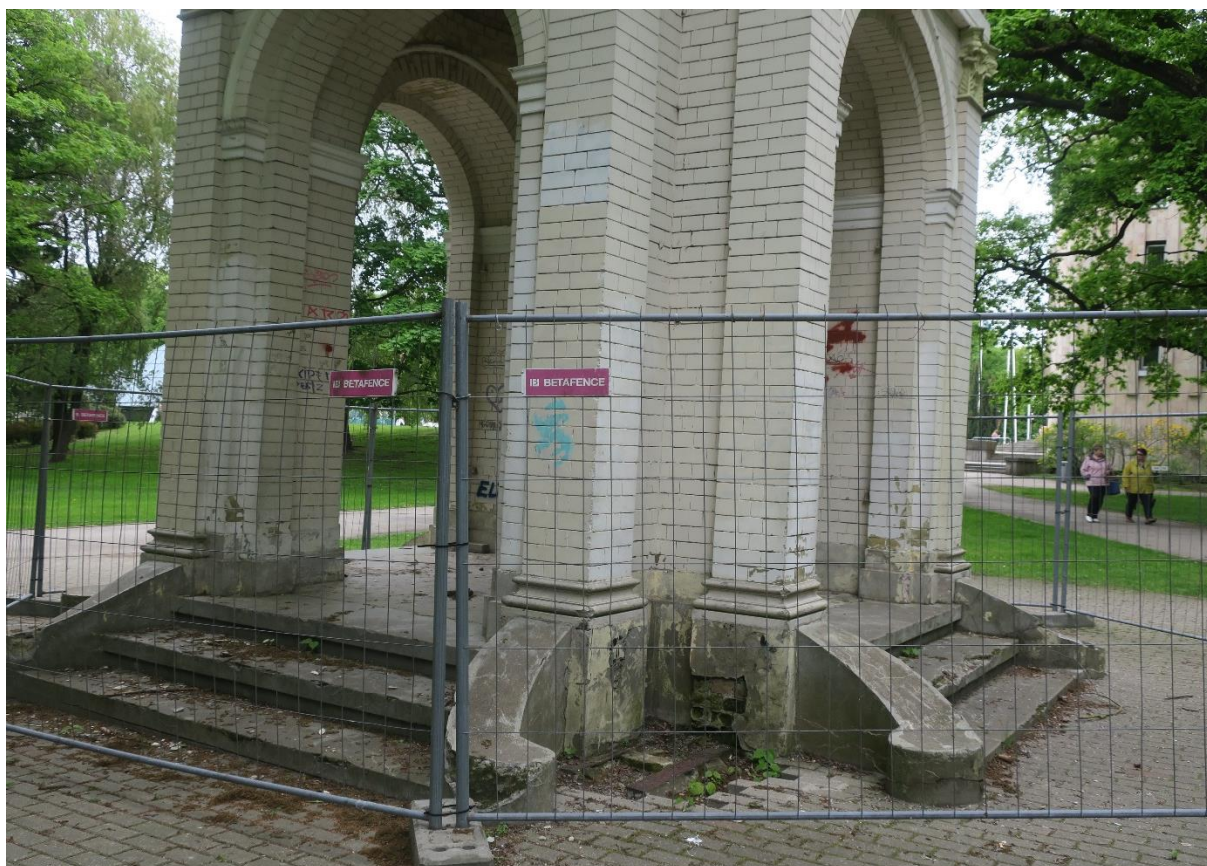
2., 3., 4.Paviljona pamatne un arku liekumi. Ķieģelis nokrāsots. Uzejas pakāpieni laboti, vietām detaļu zudumi. Pakāpienu apmales bojātas, cementa apmetums vietām zudis, nodrupis, atsedzot ķieģeļu mūrējumu.
