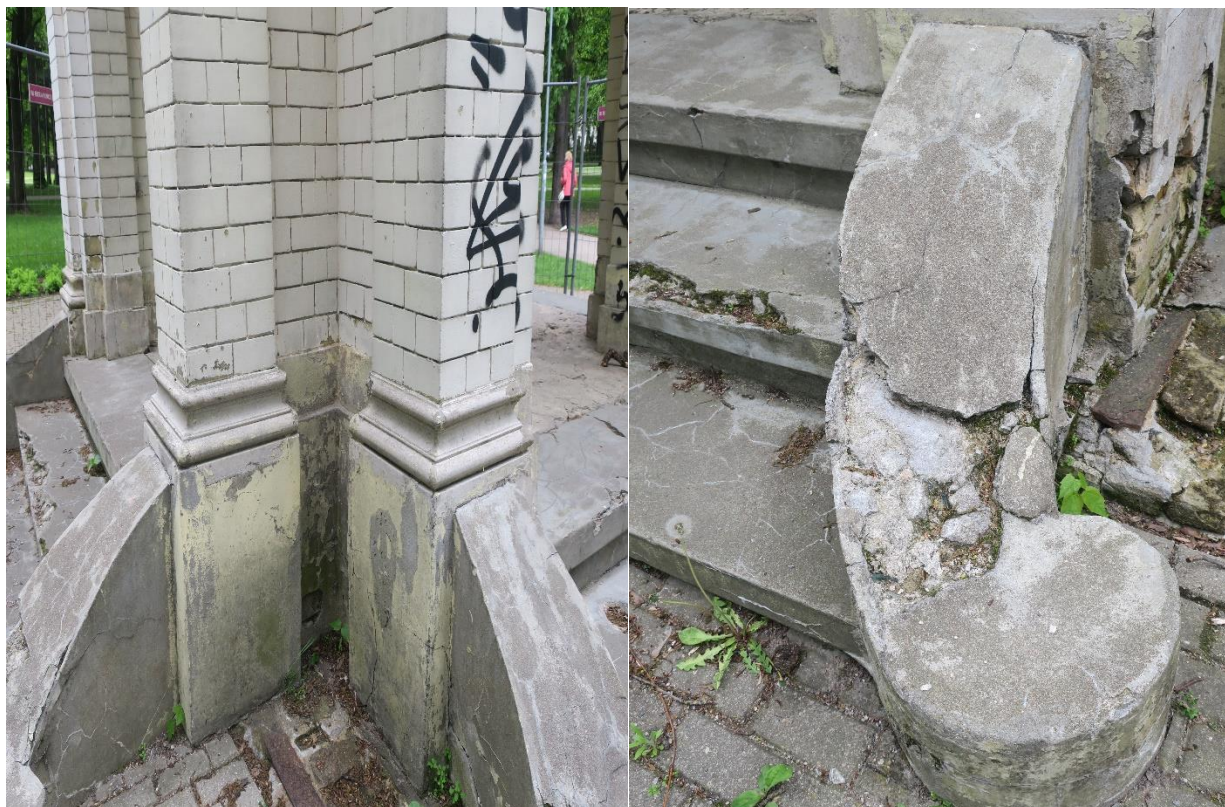
5.,6.,7.Paviljona pamatne. Redzami cementa apmetuma labojumi pilastru bāzēm, kuri veikti pavirši. Vietām apmetums nokritis. Jaunais bruģējums nepieguļ celtnes pamatnei.
