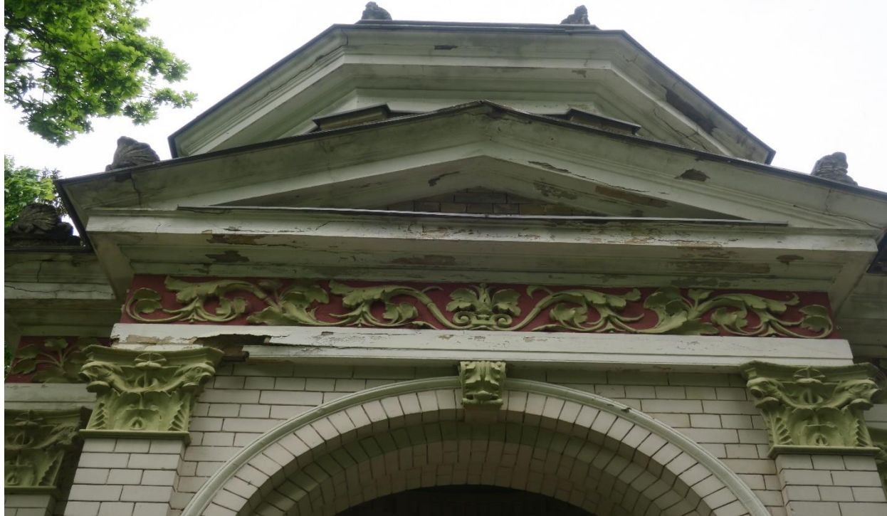
11.,12. Paviljona, pilastru kapitēļi, frīze, frontons. Krāsojums no 2000.gada. Bojātas dzegas.
