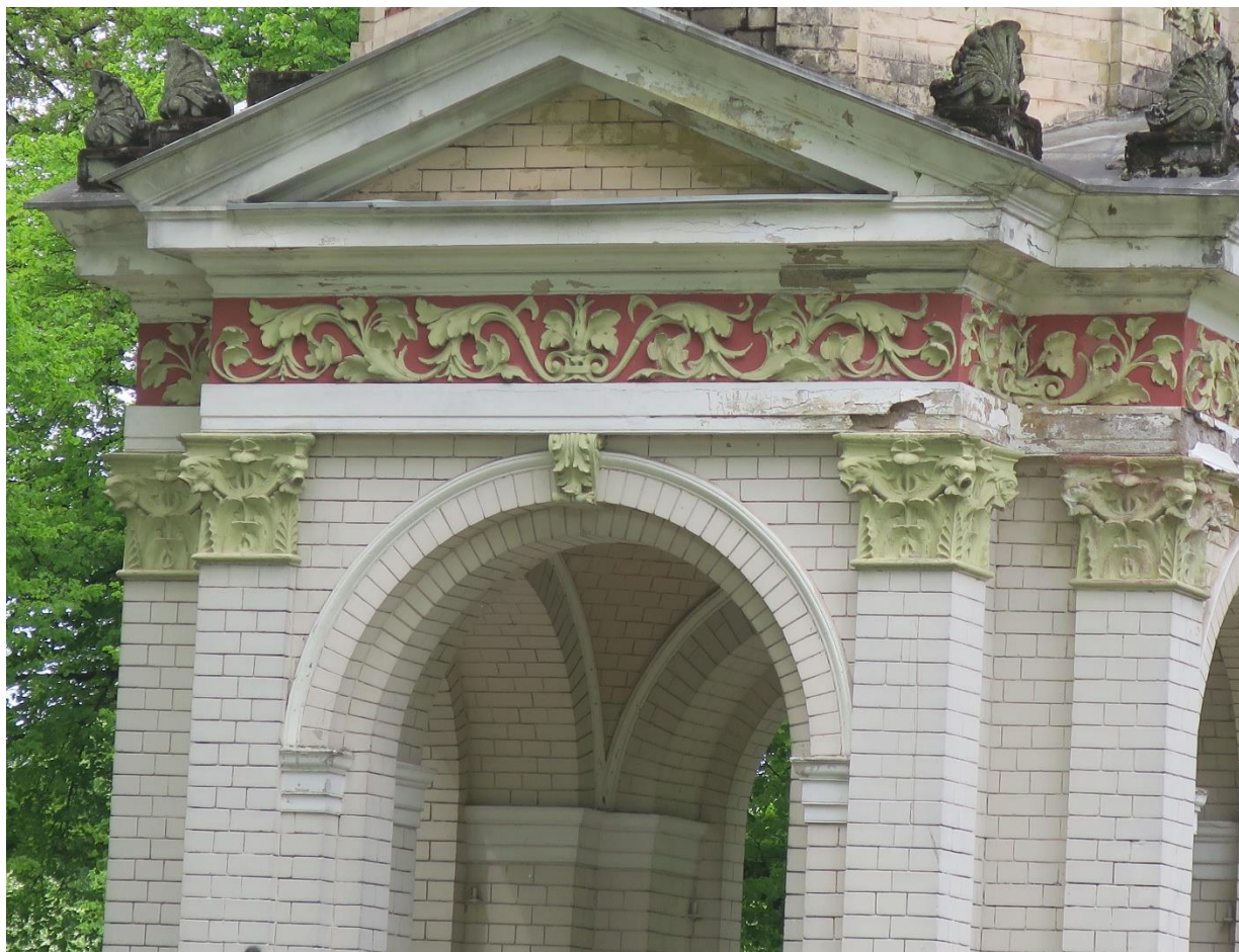
11.,12. Paviljona, pilastru kapitēļi, frīze, frontons. Krāsojums no 2000.gada. Bojātas dzegas.
