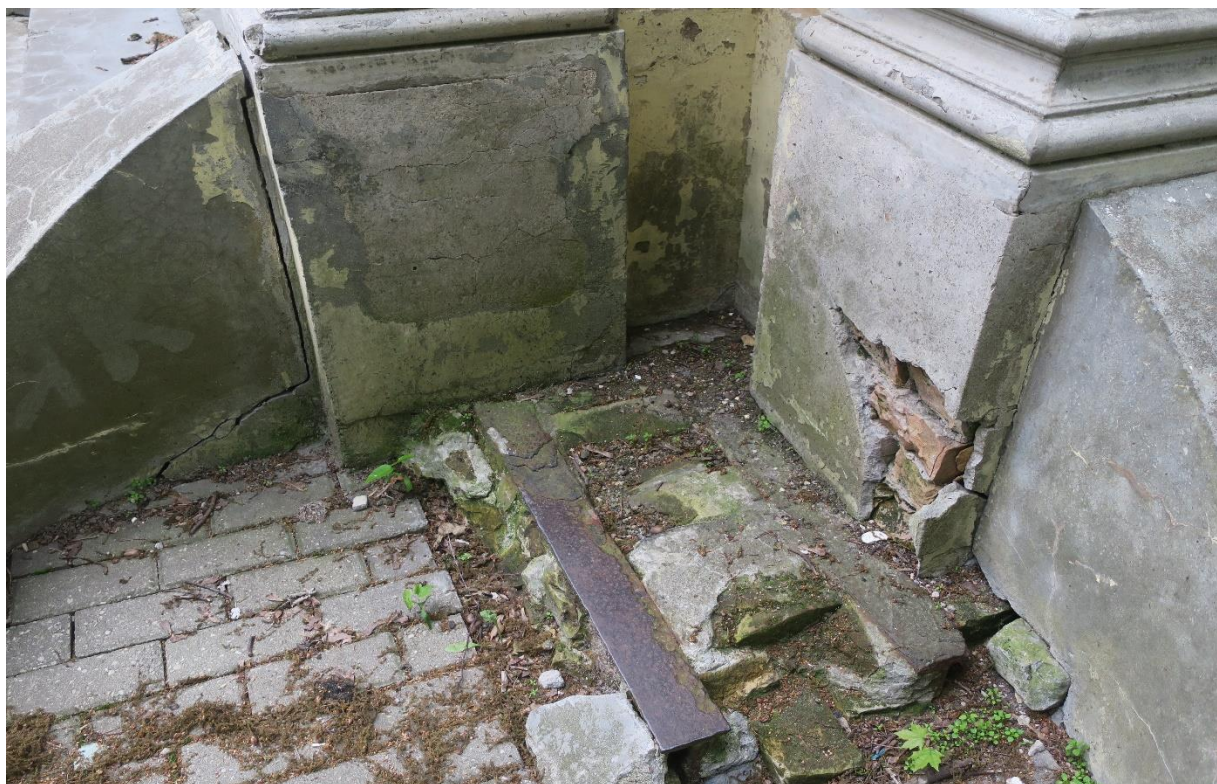
5.,6.,7.Paviljona pamatne. Redzami cementa apmetuma labojumi pilastru bāzēm, kuri veikti pavirši. Vietām apmetums nokritis. Jaunais bruģējums nepieguļ celtnes pamatnei.
