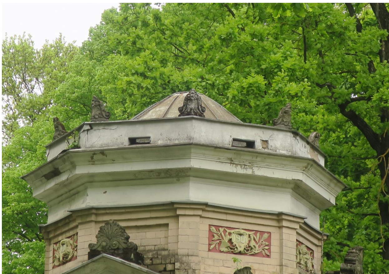
18.Kupola pamatne un augšdaļa nav oriģināla, skat. vēsturiskos attēlus. Šajā daļā akrotēriji uzlikti, kad pārveidota kupola daļa. Pamatnes daļa ir sliktā stāvoklī, plaisas, apmetuma zudumi, mitruma iedarbība. Vietām saauguši sējeņi. Kad izveidots jaunais kupols nav zināms.
